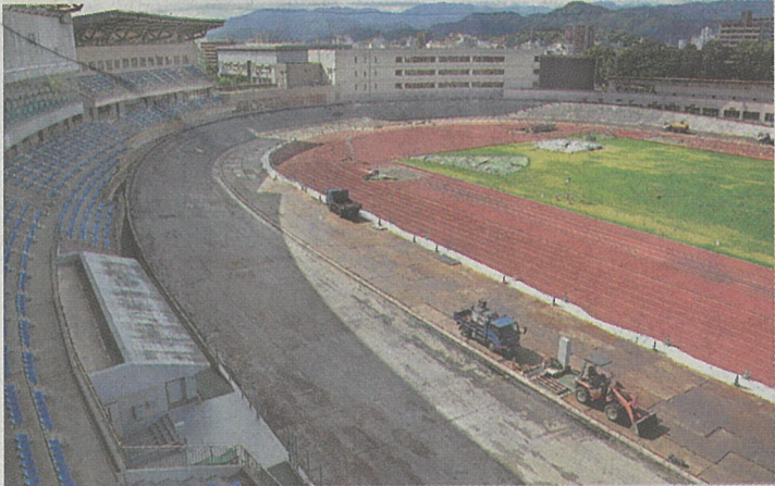
バンクの土台が現れた高知競輪場。 工事の音が響いている
