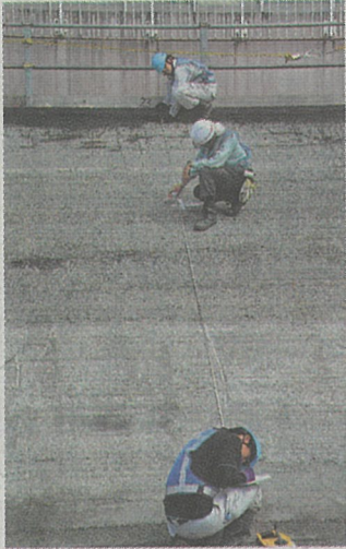
斜面を測量する作業員
